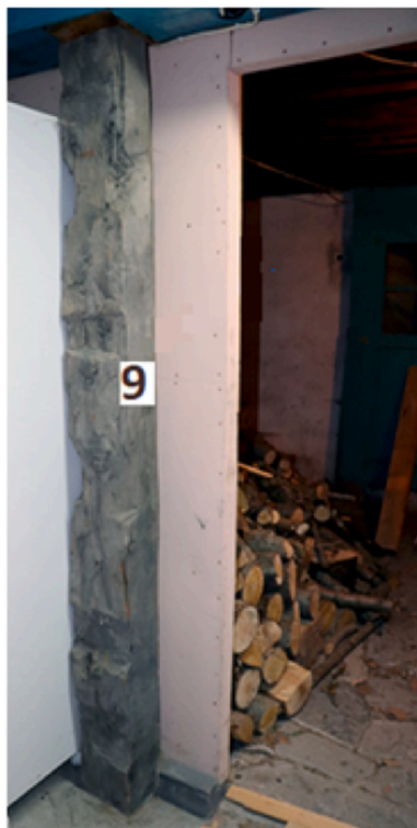
Fig. 13. Reused column – Sample 9.
