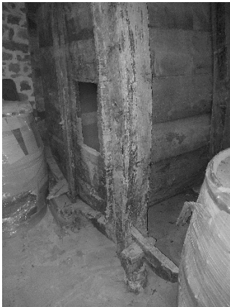
Εικόνα 3. Κατασκευαστικά στοιχεία του βαρελιού. Διαμόρφωση συνδέσεων του εξωτερικού σκελετού συγκράτησης και περίδεσης των σανίδων με εγκοπές και σφήνες.
