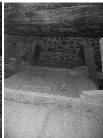
Εικόνα 3. Κατασκευαστικά στοιχεία του βαρελιού. Διαμόρφωση συνδέσεων του εξωτερικού σκελετού συγκράτησης και περίδεσης των σανίδων με εγκοπές και σφήνες.
