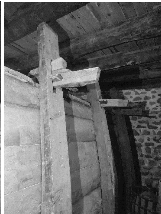
Εικόνα 3. Κατασκευαστικά στοιχεία του βαρελιού. Διαμόρφωση συνδέσεων του εξωτερικού σκελετού συγκράτησης και περίδεσης των σανίδων με εγκοπές και σφήνες.
